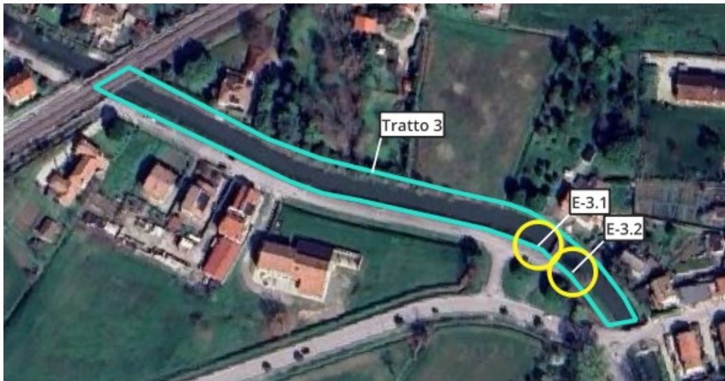
Figura 22. Ubicazione dei cedimenti spondali lungo il tratto 3.
