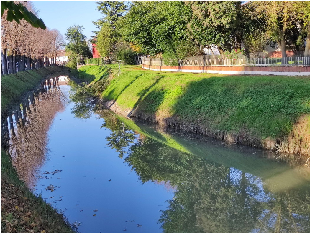
Figura 37. Vista da valle della difesa spondale presente alla progressiva 965.35.
