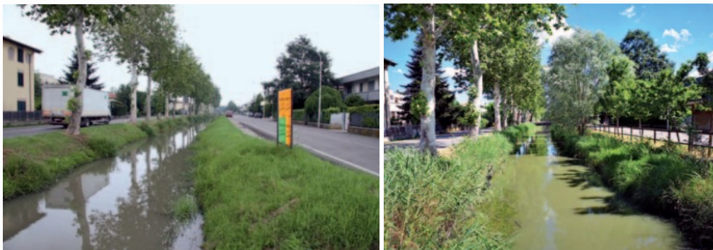
Figura 32: Esempio di esperienze provenienti da altri comuni per la riqualificazione di tratti urbani di corsi d'acqua. Creazione di una banchina interna allagabile lungo il Canale di San Giovanni (Comune di San Giovanni in Persiceto – Provincia di Bologna). Nell'immagine di sinistra è possibile vedere il canale prima dell'intervento (2008) e nell'immagine di destra il canale a distanza di 12 anni (2020). Si nota la palificata che ha permesso di ricavare lo spazio per la creazione della banchina e per la messa a dimora di vegetazione acquatica, spondale e arbustiva. (Fonte: Consorzio della Bonifica Burana e Consorzio di Bonifica Pianura di Ferrara).
