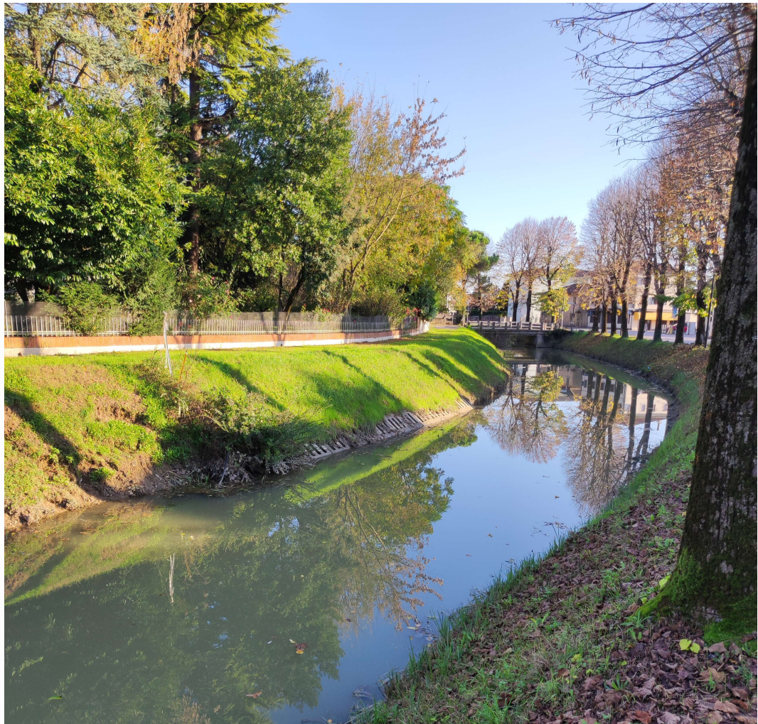
Figura 36. Vista da monte della difesa spondale presente alla progressiva 965.35.
