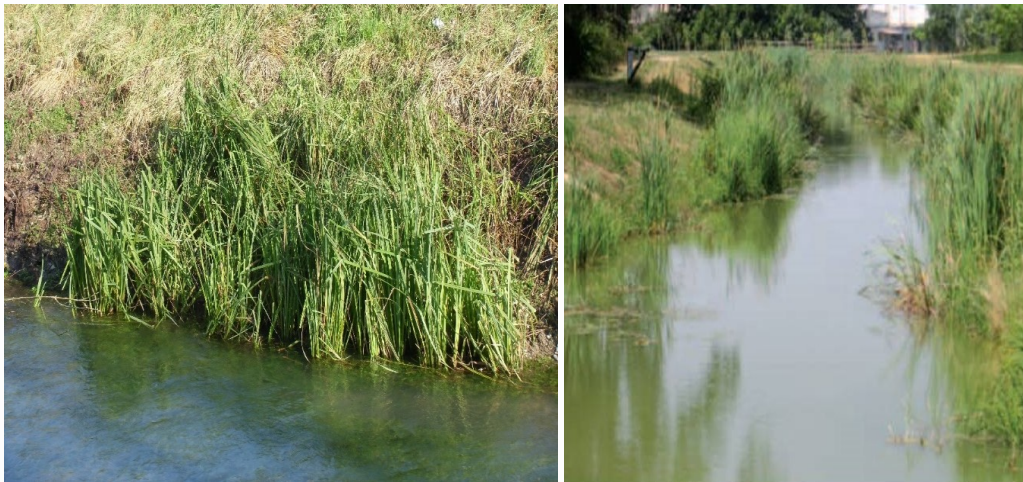
Figura 31: Viste di alcuni esempi di ripristino mediante inserimento di cuneo vegetato.
