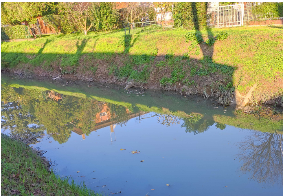
Figura 19. Criticità E-2.1. Principio di erosione lungo la sponda sinistra del colatore.
