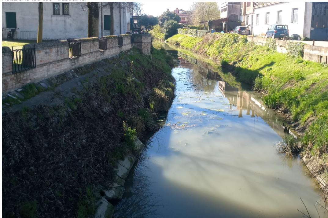
Figura 16. Veduta a valle del ponte di inizio intervento. L'elemento di criticità E-1.1 è posto sotto il piede sinistro della sponda mentre l'elemento E-1.2 è osservabile lungo la riva destra.
