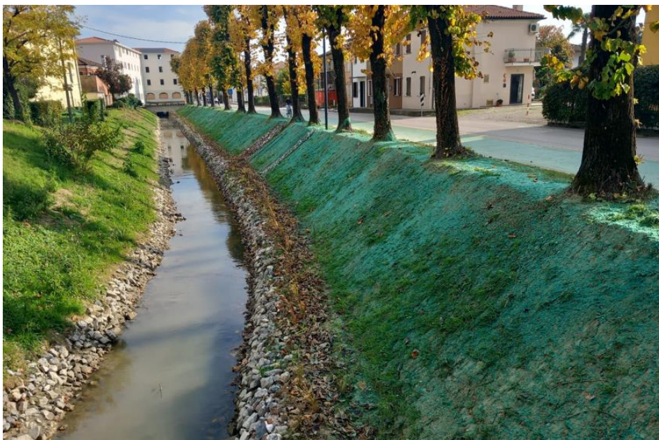
Figura 7: Tratto a Valle della passerella pedonale di Piazzetta Berre Etang fino all'imbocco del tombinamento del centro abitato. Sulla destra la golena vegetata e la sponda destra ripristinata, stabilizzata con idrosemina.
