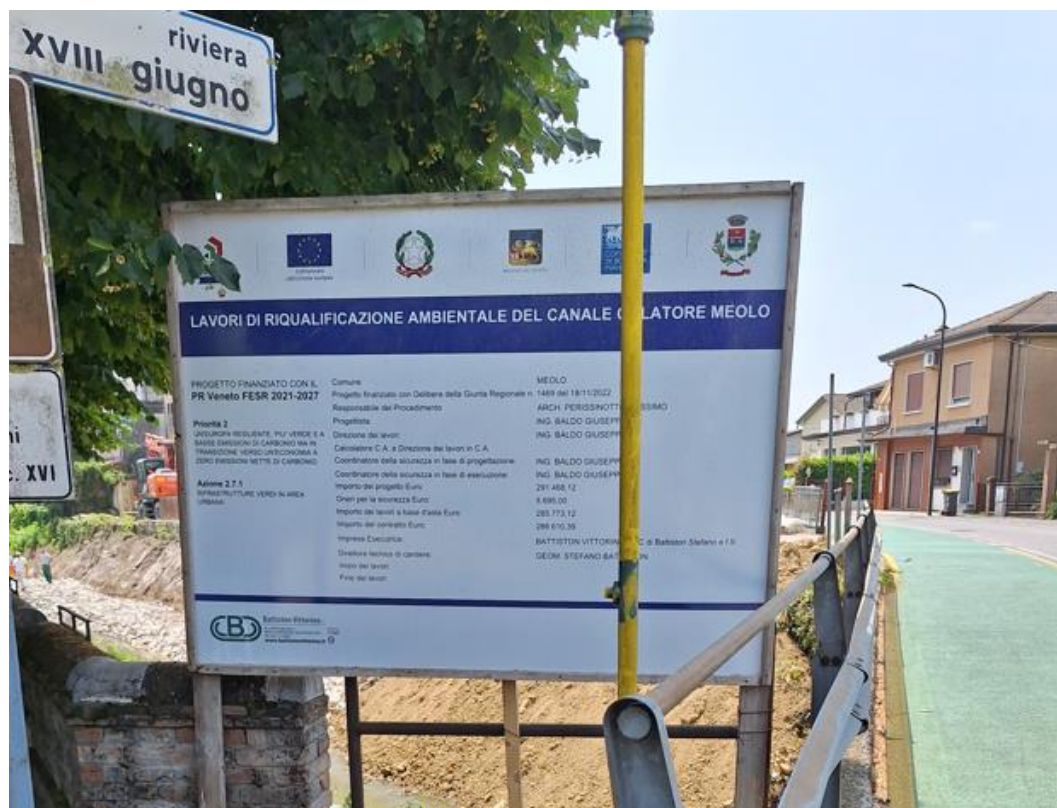
Figura 2: Cartello di Cantiere.
