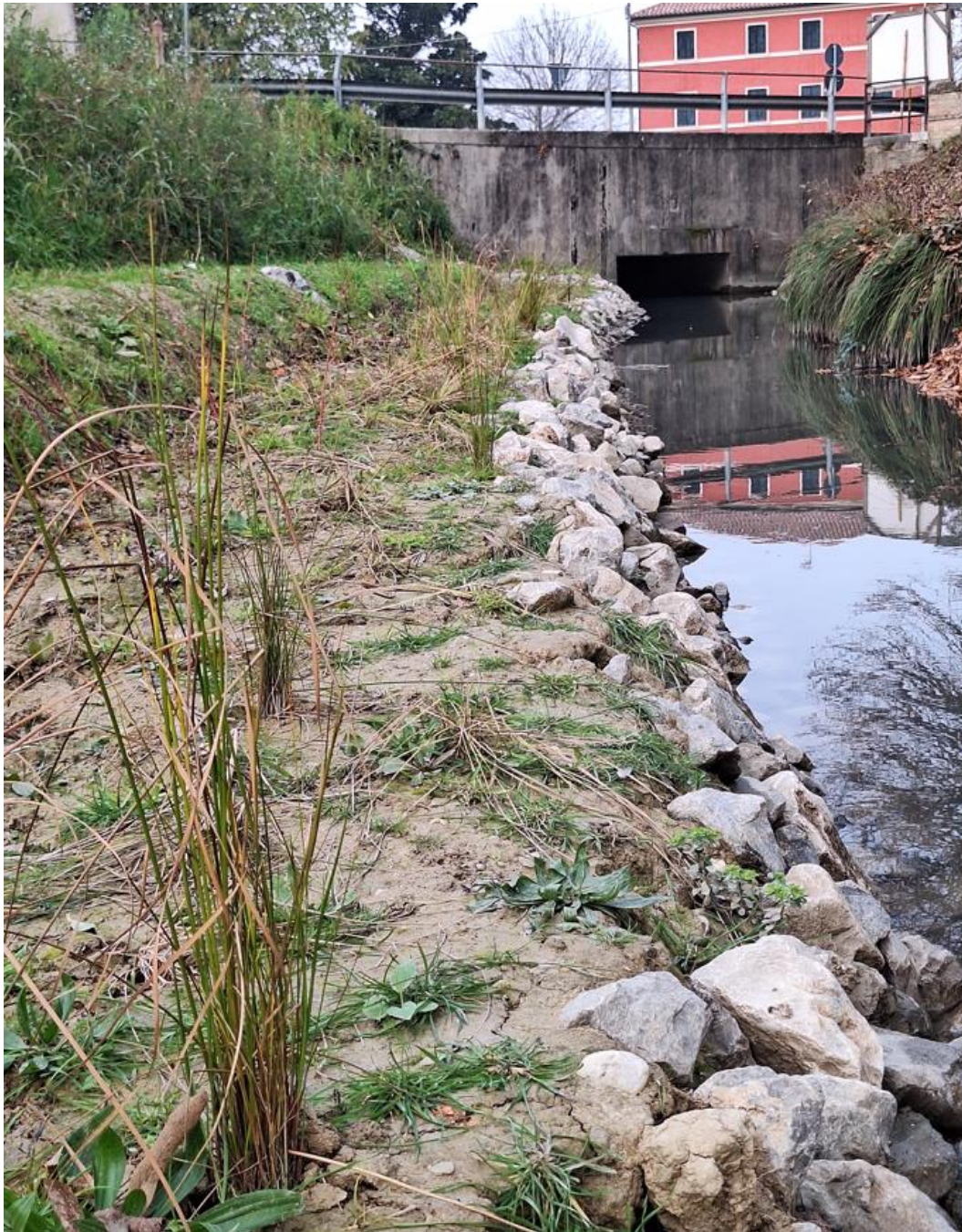
Figura 3: Inizio area di intervento Tratto 1. Vista sul ponte di Riviera XVIII giugno. In basso la golena popolata di specie elofitiche e la pista per la manutenzione sopraelevata rispetto alla quota della golena.
