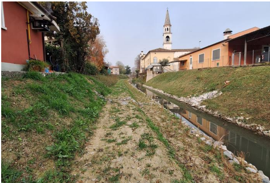
Figura 4: Tratto 1 visto verso monte (nord) nei pressi della passerella di Piazzetta Berre Etang. Da sinistra: Sponda sistemata – Pista pedonale per la manutenzione – Golea vegetata – Canale Colatore – Ripristino al piede e presidio in roccia nei punti di scarico esistenti.
