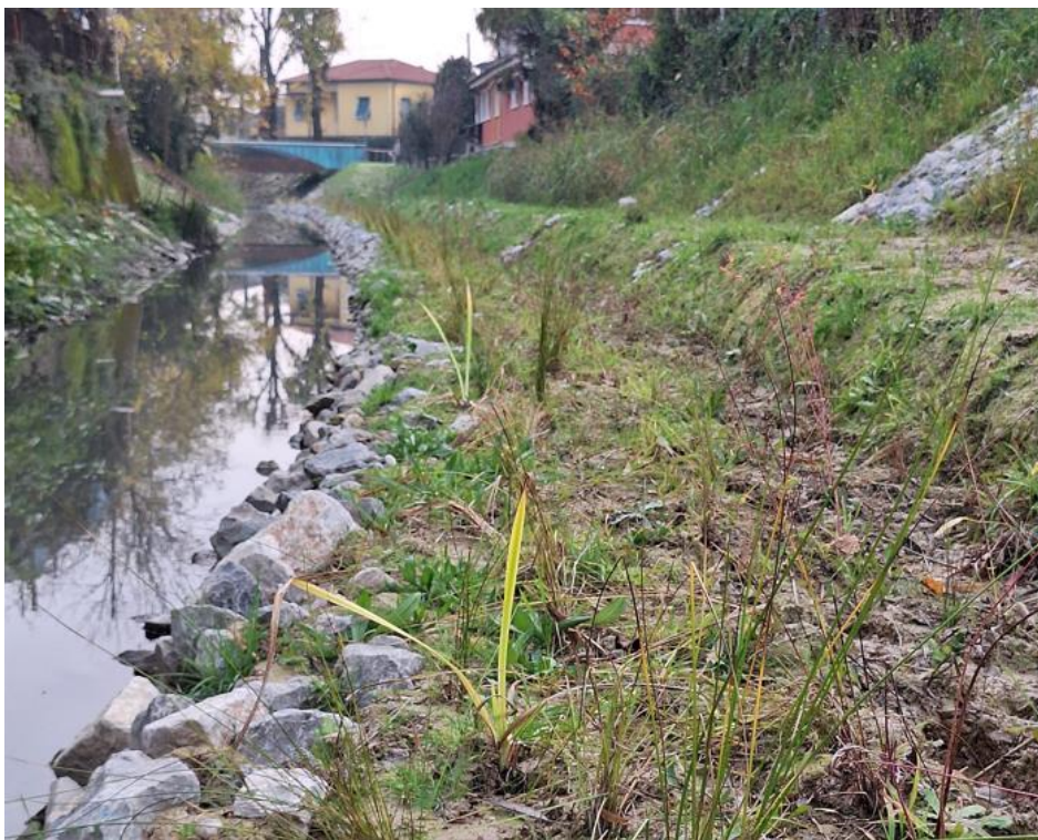
Figura 5: Dettaglio della gola vegetata con specie elofitiche in direzione sud. Sullo sfondo la passerella pedonale di Piazzetta Berre Etang.
