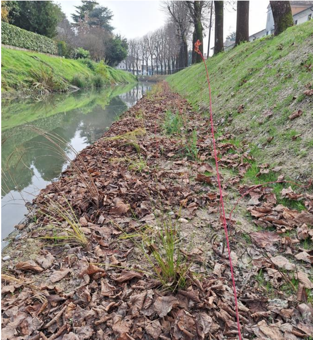
Figura 9: Tratto all'uscita del tombinamento del Centro cittadino (via Roma). Dettaglio della golena vegetata con specie elofitiche in direzione sud.
