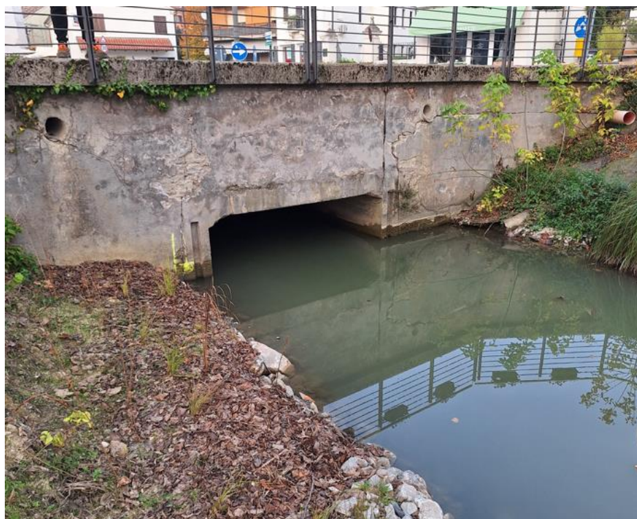
Figura 8: Tratto all'uscita del tombinamento del Centro cittadino (via Roma). Sulla sinistra la golena vegetata.
